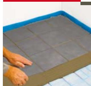
Укладка керамической плитки
