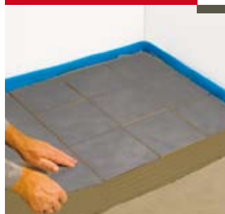
Укладка керамической плитки
