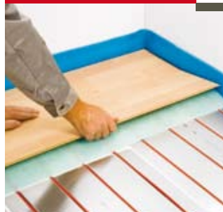
Укладка деревянного пола
