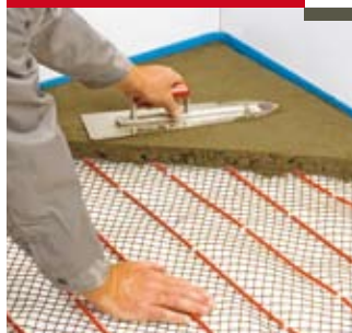
Нанесение стяжки
