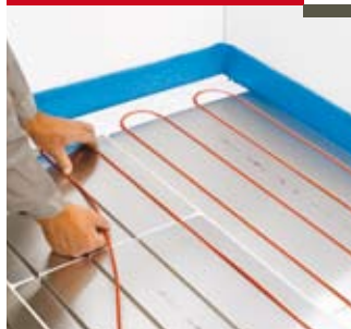
Укладка греющего кабеля
