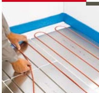
Укладка греющего кабеля
